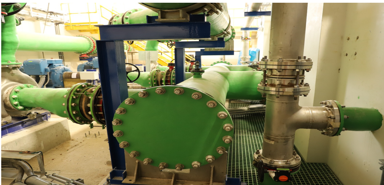
Fabricación de spool PRFV para proyecto de PROVISUR.
