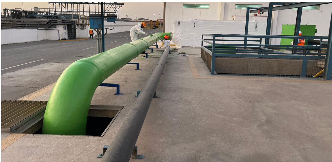
Fabricación y montaje de tuberías DN1400- PLANTA TABOADA-CALLAO
